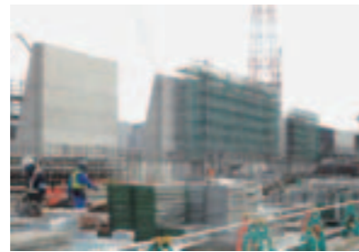
防潮堤工事状況
