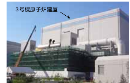
防潮壁設置工事(8月28日撮影)
