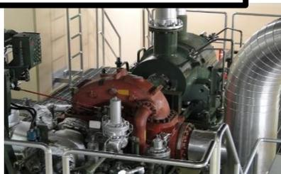
原子炉隔離時冷却系
