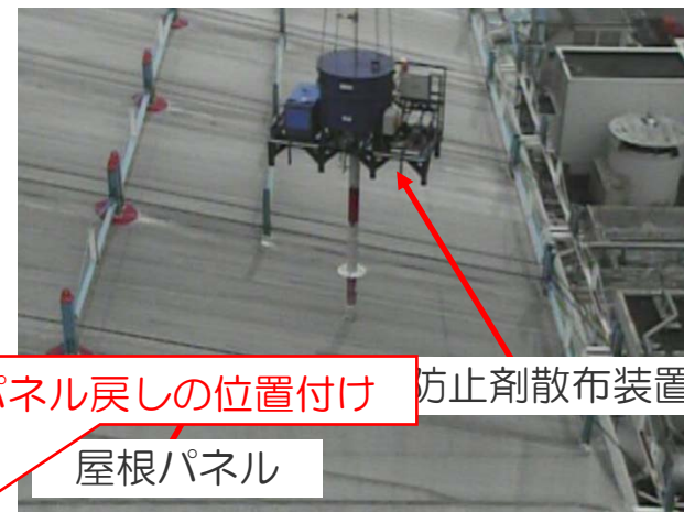
屋根パネルへの孔あけ状況
