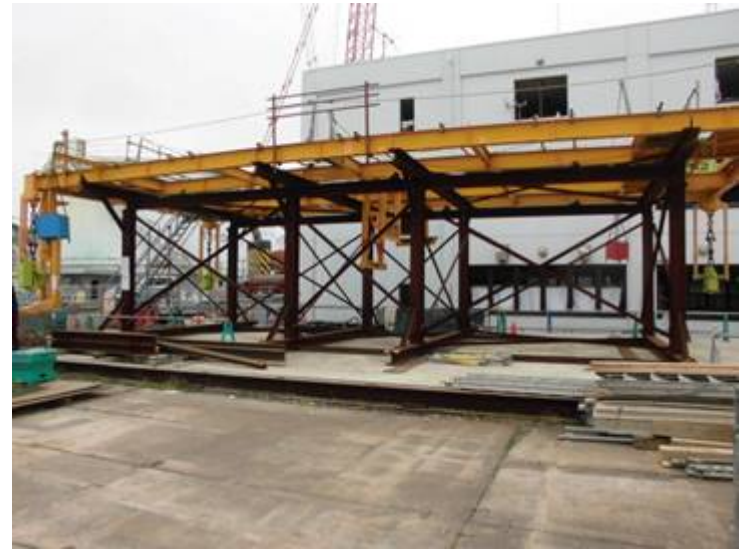
屋根パネル取り外し用装置・架台
