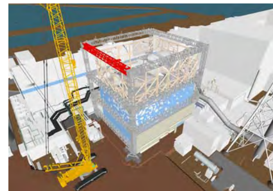
③フレーム解体開始
