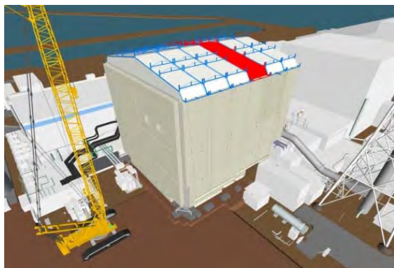
①屋根パネル解体開始
