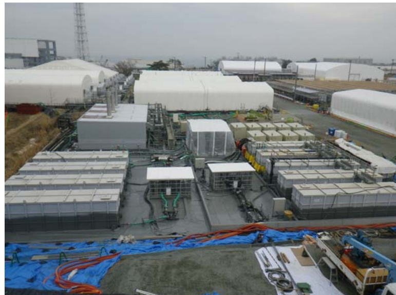
コンクリート基礎・機器フェーシング
