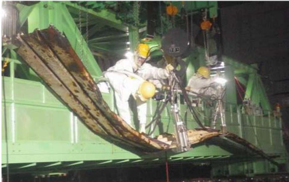
使用済燃料プールキャスクピット内瓦礫 (制御棒及びガイドチューブ)
