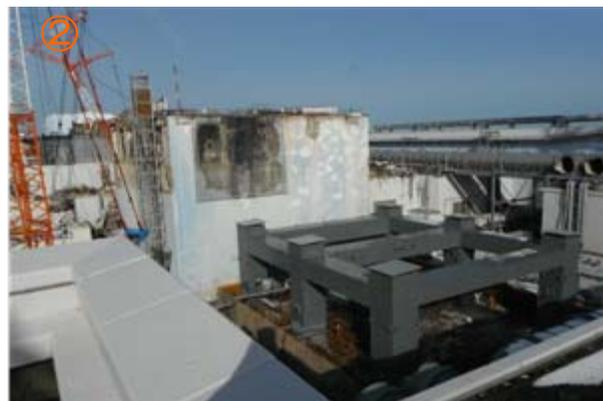
クレーン支持用架構 第1節建方完了
