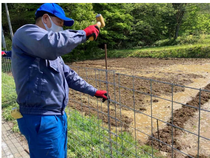
獣害対策用の金網設置
