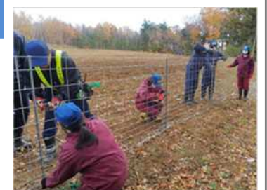
設置作業の様子
