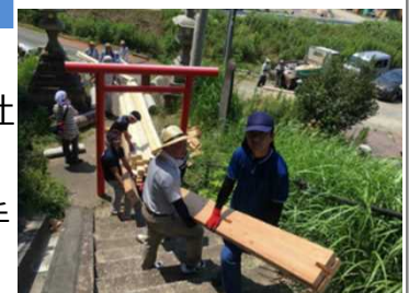
木材の荷揚げ
