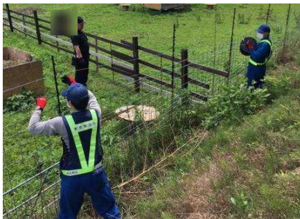
営農再開に伴う電気柵設置
