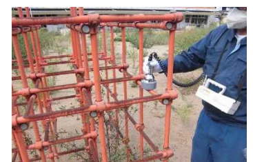
【富岡町】残置物の表面汚染密度測定
