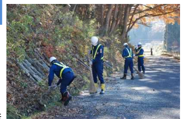
伐採した樹木の運搬ならびに集積の様子
