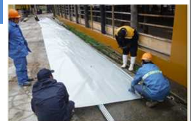
シート張りの様子
