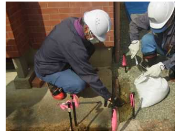
土壌除去状況（楡葉町）
