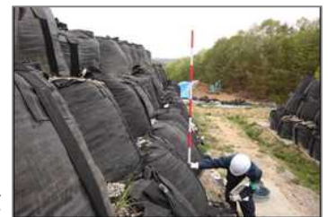
遮蔽土のう状態調査状況
