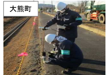
町道除染後の線量調査
