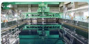
約12m×約29m×水深約11m。容量は約3,800m<sup>3</sup>で燃料約6,700本を保管することができます。
