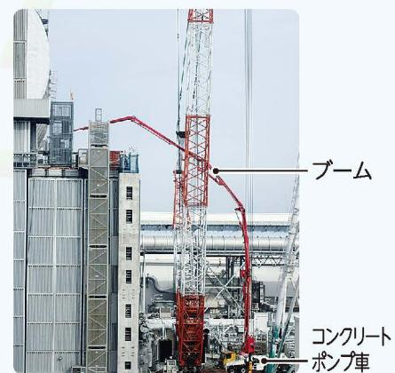
▲コンクリートポンプ車で3号機の地上約35mに設置されている受口へ、ブームを延ばしている様子。
