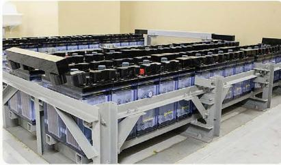
主に電源設備の制御・計測・故障表示等の電源として使用します。構内各電源設備に配備しています。(図中の表示箇所は一例)
