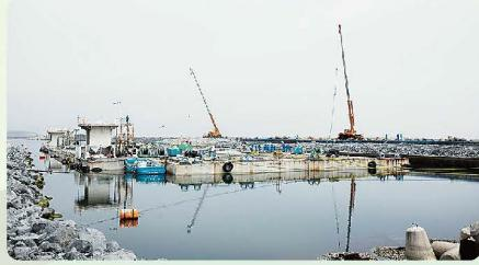
縦136m、横46m、高さ3mのメガフロートが、津波漂流物となり周辺設備を損傷させるリスクがあることから、2020年度上期頃までに、着底させ、護岸および物揚場の一部として有効利用します。
