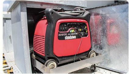
持ち運びが可能な発電機です。主に照明や通信設備および計測器等の電源として使用します。構内各所に配備しています。(図中の表示箇所は一例)
