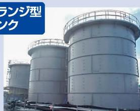
鋼材をボルト締めしたタンク
