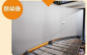
\*プラスト除染とは、加速させた小さな鉄の粒を対象物の表面に衝突させ、表面を削り取ることにより、対象物表面に付着している放射性物質を取り除く除染方法です
