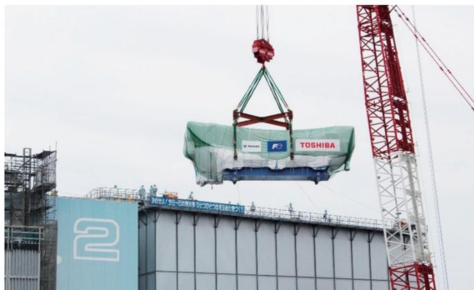
クレーンによる燃料取扱設備の引き上げの様子
