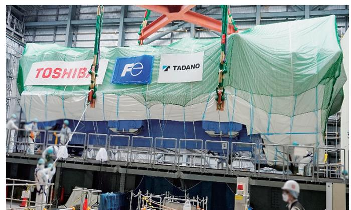
燃料取り出し用構台内でのレールへの据え付けの様子
