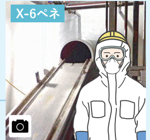
5号機原子炉格納容器の内側より撮影
