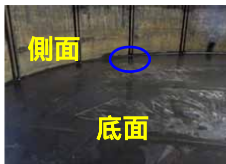
【参考】同型タンク内面写真（水抜き後）
