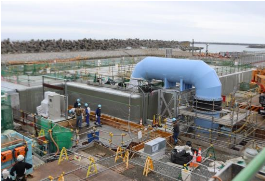
放水立坑（上流水槽）全景 （2023年6月）
