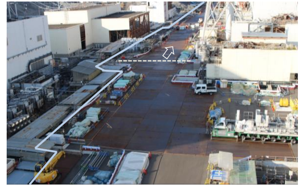
①フェーシング工事完了後 (フェーシング上に鉄板敷設)：全景 (2024.2)
