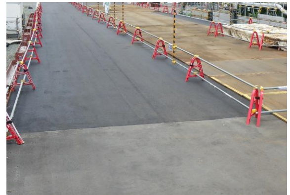
②アスファルト舗装完了 (2023.9)
