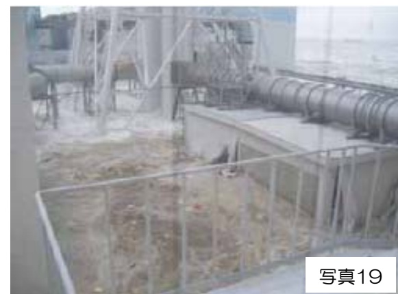
15時37分24秒頃（補正後） 第2波（2段目）の浸水により、 10m盤タンクが水没
