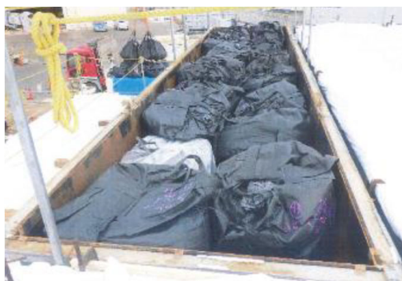
手順3.ノッチタンクから取り出し (参考:土のう袋のノッチタンク保管時の写真)
