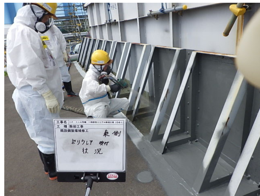
堰の補強(防水処理)の状況 (2025年5月27日撮影)
