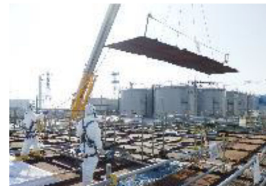
手順2.ノッチタンク蓋の開放 (参考:ノッチタンク蓋開閉時の写真)
