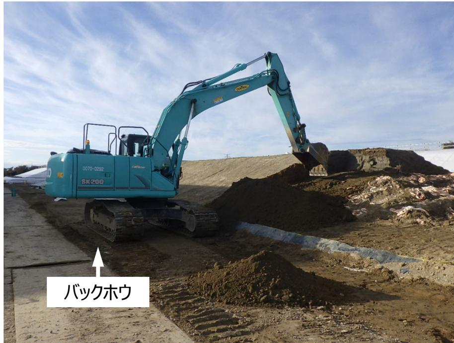
写真1. 第2層目の撤去作業の状況
