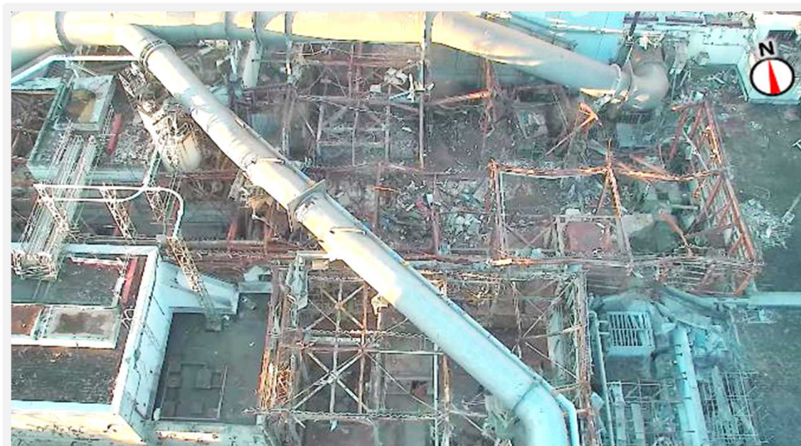
主排気ダクト撤去開始前 (2022年1月撮影)
