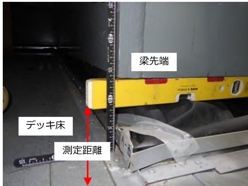
【梁先端部 計測状況】
