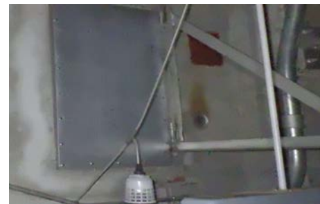
ダクト開口部 閉止後
