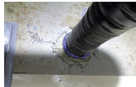
配管貫通部 閉止後
