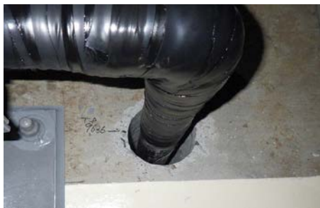
配管貫通部 閉止前
