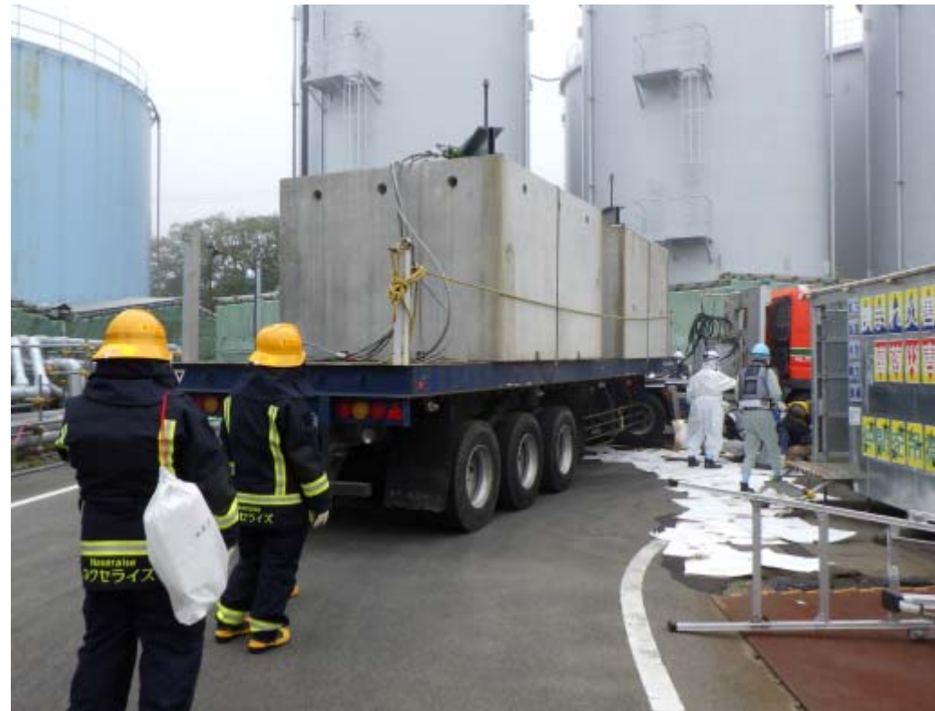
吸着マットによる油の回収作業中
