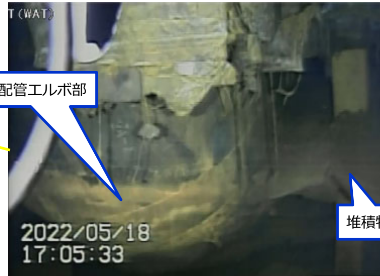
写真1.PLR(A)配管の状況
