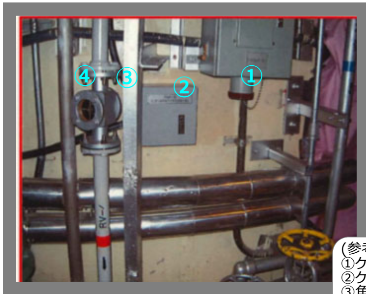
(参考写真)2011年事故前の状況
