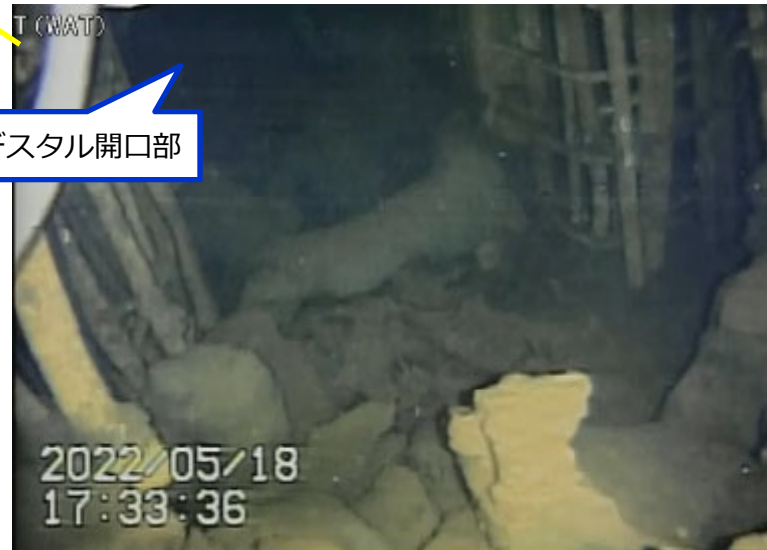
写真3.ペDESTAL開口部前の堆積物の状況
