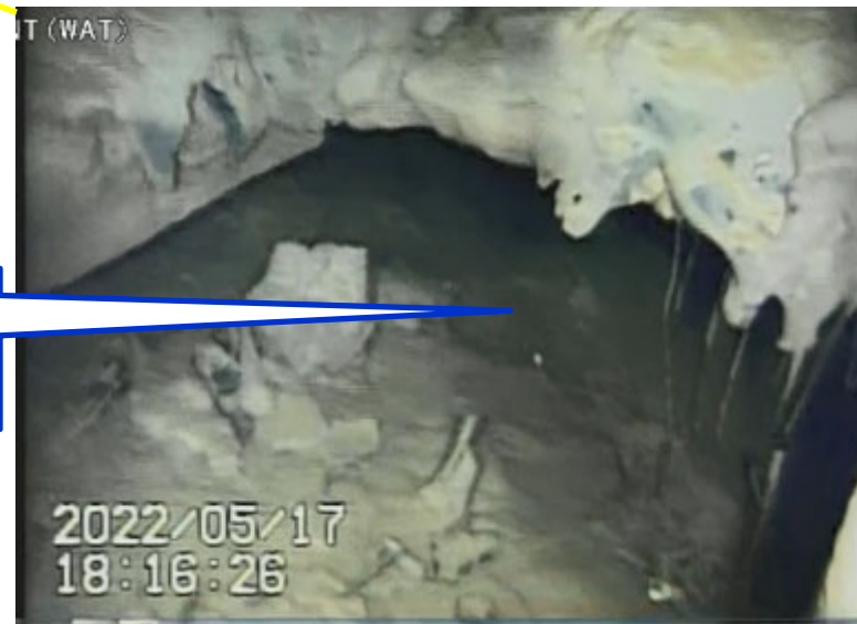
写真3.PCV底部の堆積物の状況(空洞内部)
