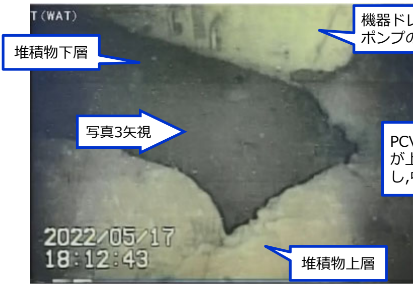
写真2.PCV底部の堆積物の状況
