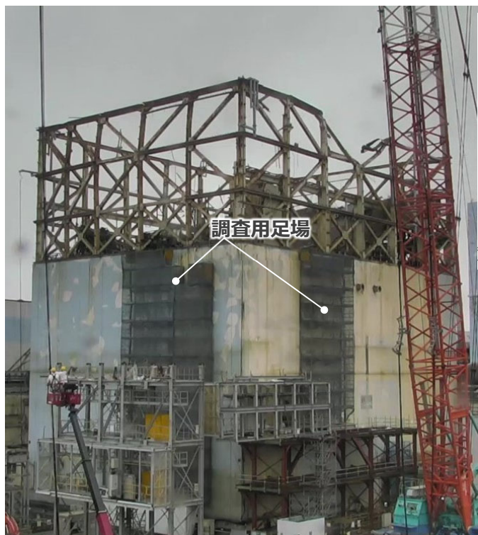
写真1.現場状況(北西より) (撮影：2022年3月18日)
