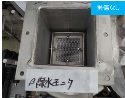
既設ALPS β線水モニター受 タンク
