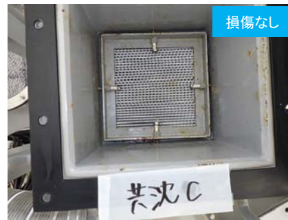
既設ALPS 共沈タンクC
