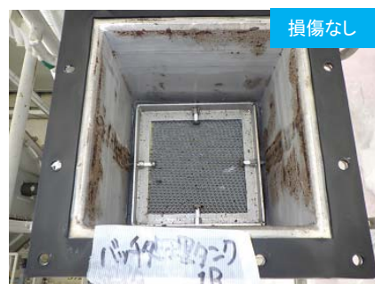
既設ALPS バッチ処理タンク1B
