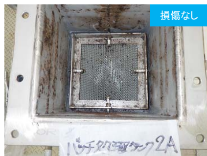
既設ALPS バッチ処理タンク2A
