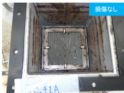
既設ALPS バッチ処理タンク1A
