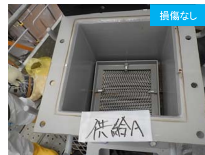
既設ALPS 供給タンクA
