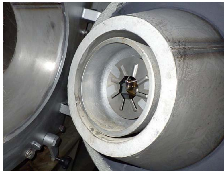
交換後のバーナ部の耐火物（2021年2月撮影）
