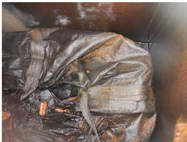
【水の回収後のノッチタンク（北）内の様子】
