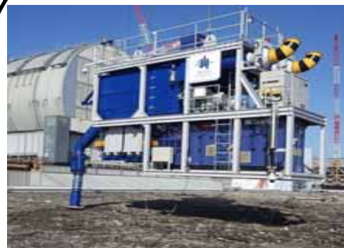
【小型ガレキ・ルーフブロック・砂等の吸引の様子】
