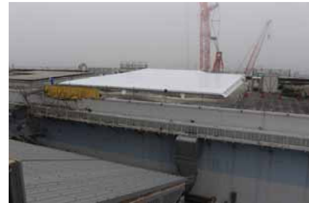
【雨水カバー設置作業の様子】 (撮影日：7月20日)
