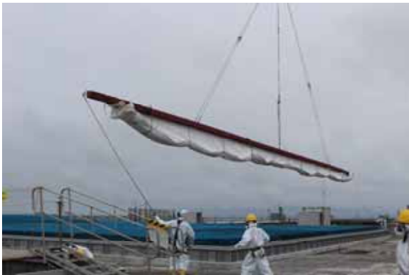
【雨水カバー設置に向けた準備作業の様子】 (撮影日：7月17日)
