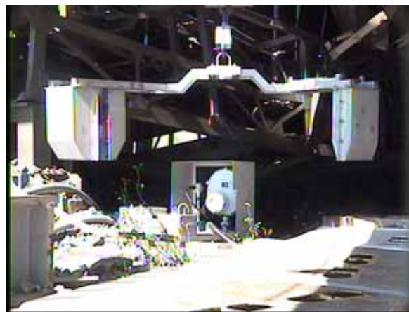
図2.固定スペーサ設置作業の状況 (6月17日撮影)
