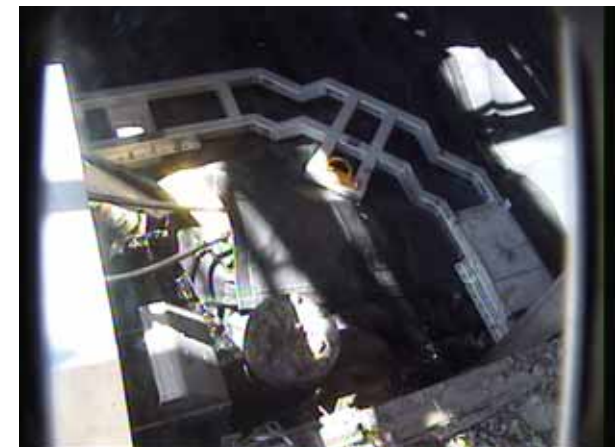
図3.固定スペーサ設置完了後の状況 (6月17日撮影)
