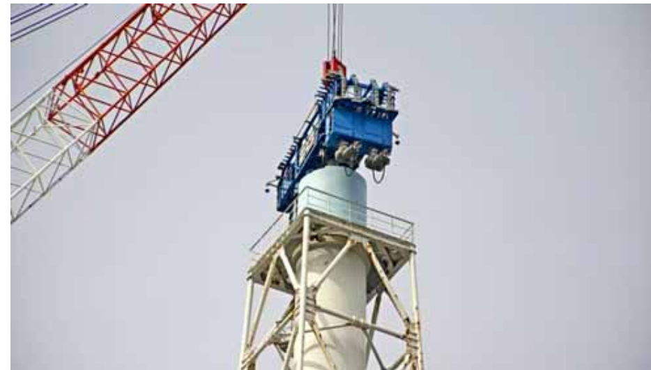
「1 / 2号機排気筒解体」 地元企業による廃炉作業への参画
