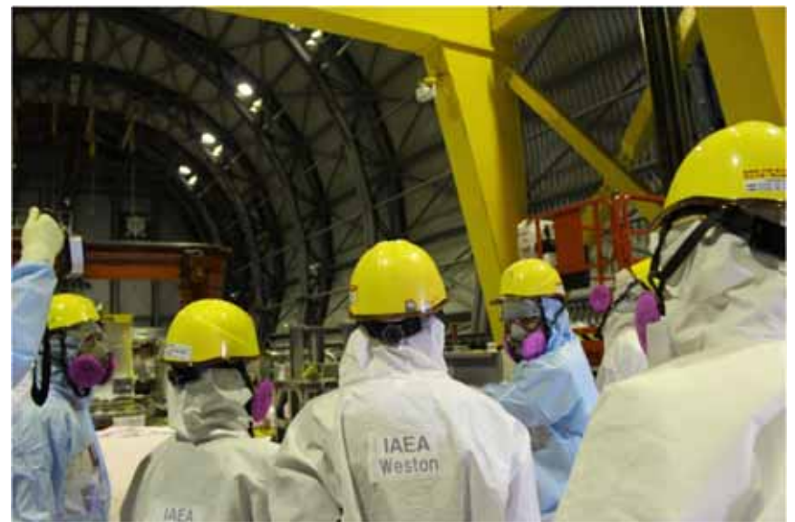
3号機原子炉建屋オペレーティングフロア
