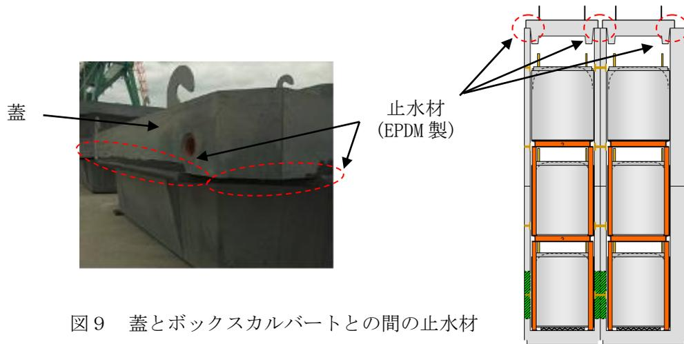
図9 蓋とボックスカルバートとの間の止水材
