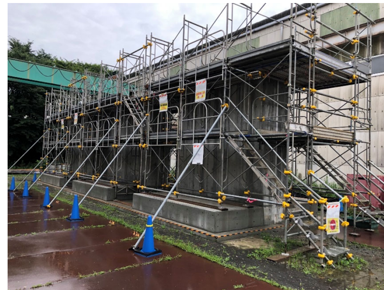
写真1. 試験体構築完了
