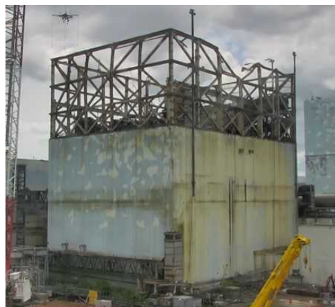
1号機原子炉建屋全景（2021年5月26日時点）
