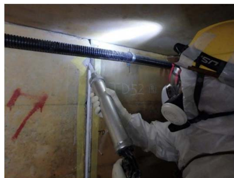
シール材充填状況
