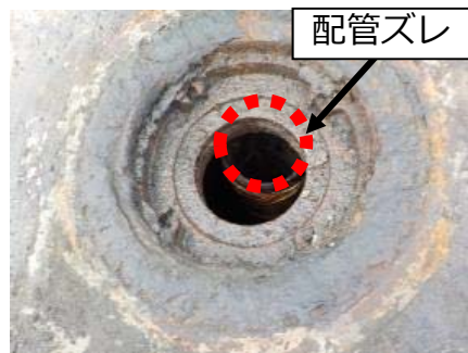
②ルーフドレン改修着手前
