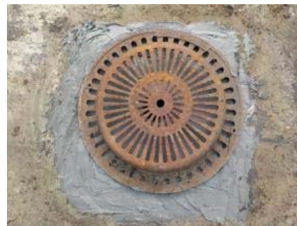
②ルーフドレン改修完了
