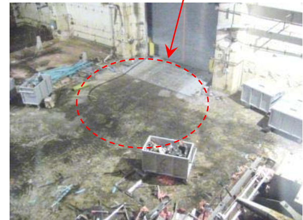
10月1日のオペフロ状況 (雨漏れによる水たまりの発生は確認されていない)
