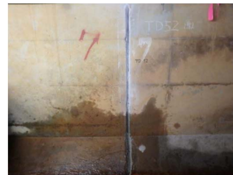
目地部カット完了
