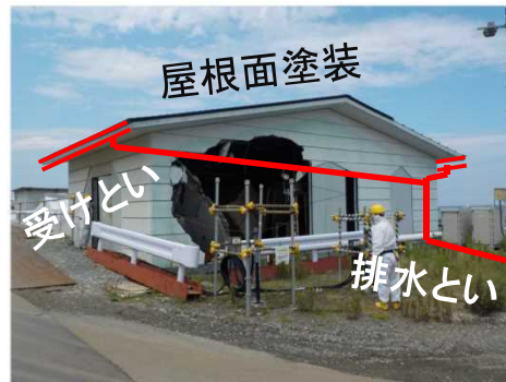
屋根塗装＋雨樋設置
