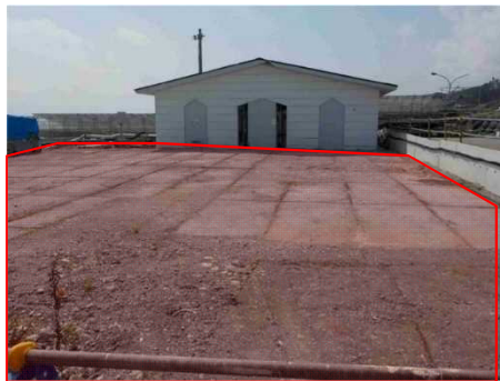
砂利部のアスファルト舗装
