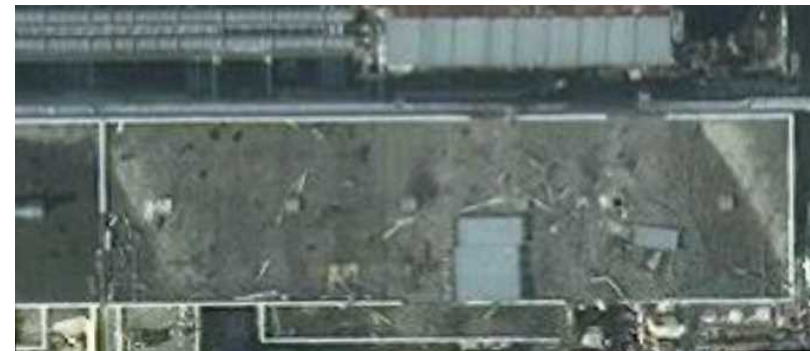
ヤード整備後に遠隔ガレキ撤去＋防水（3T/B）
