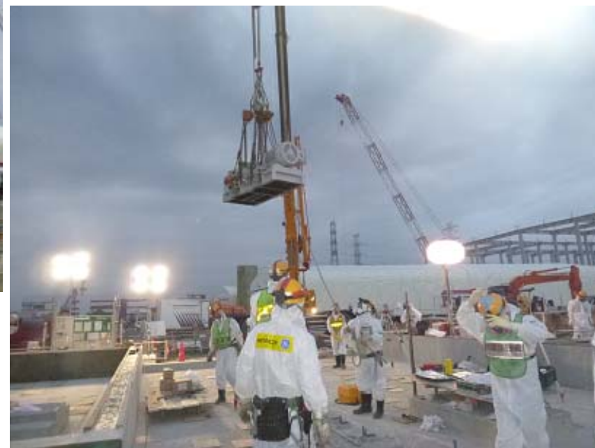
機器据付状況
