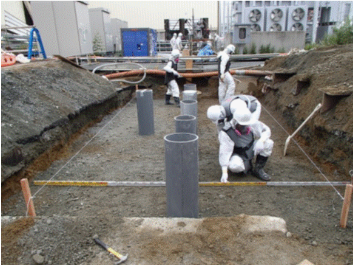
写真④-3 6BLK開閉所南試掘中
