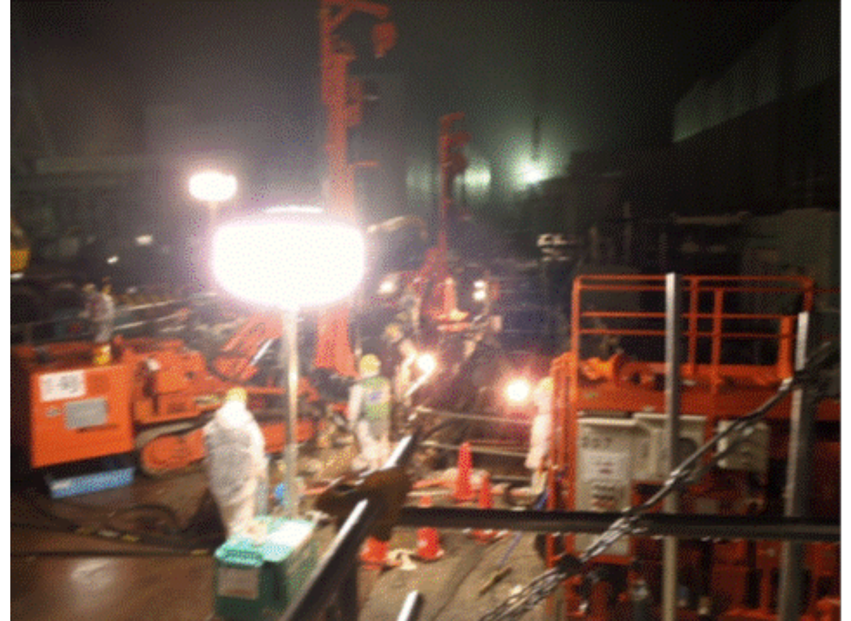
写真⑤-1 7BLK軽油タンク北削孔中
