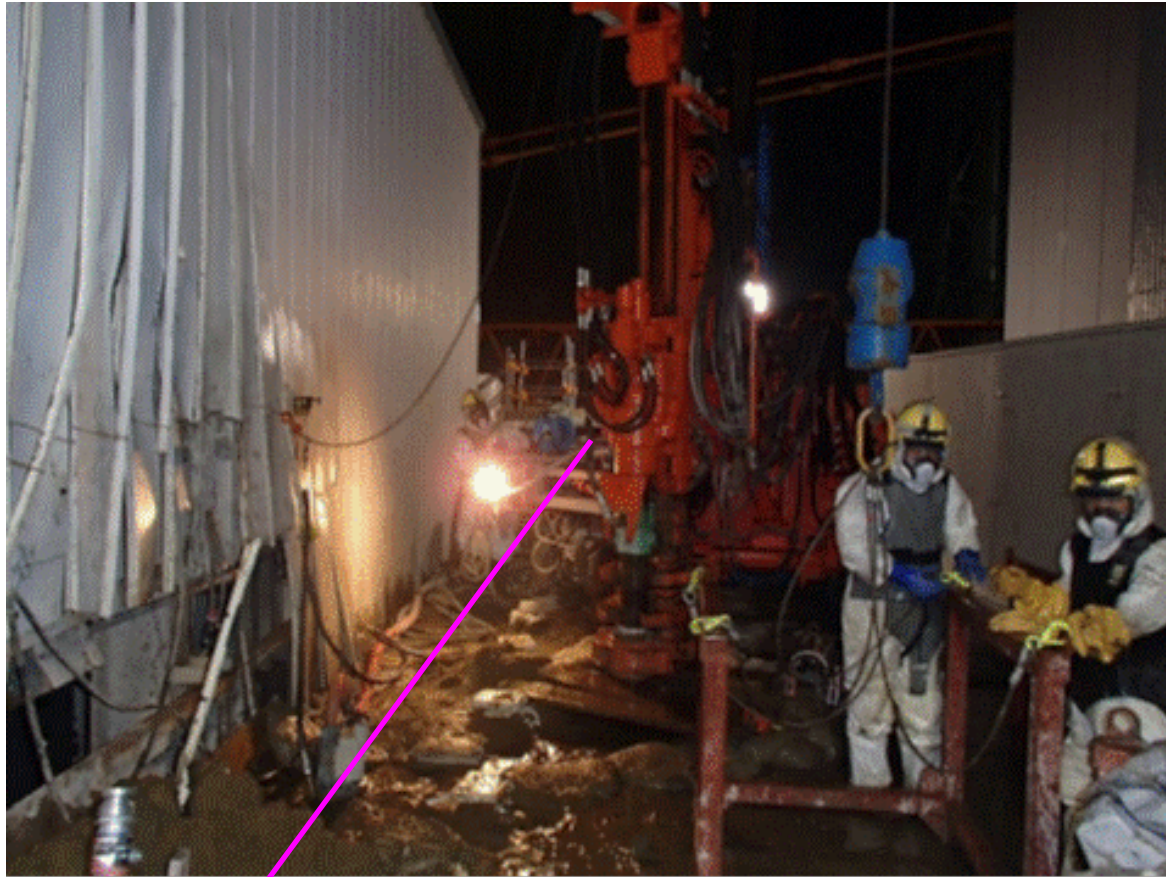
写真②-2 3BLK削孔中 (1セツト)
