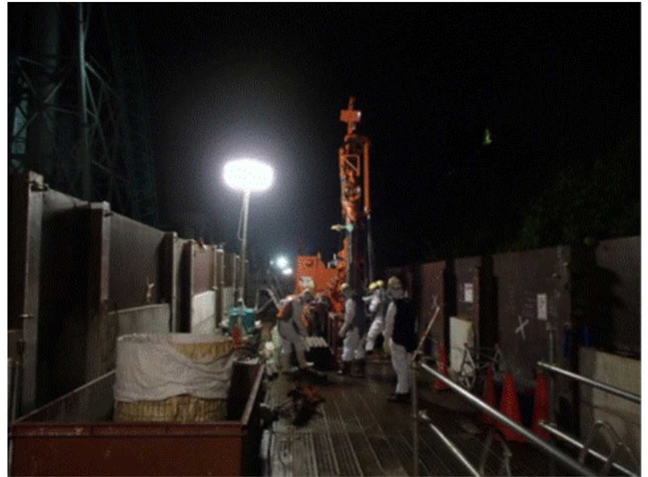
写真③-1 5BLK削孔中 #1電気洞道北側 (2セツト)
