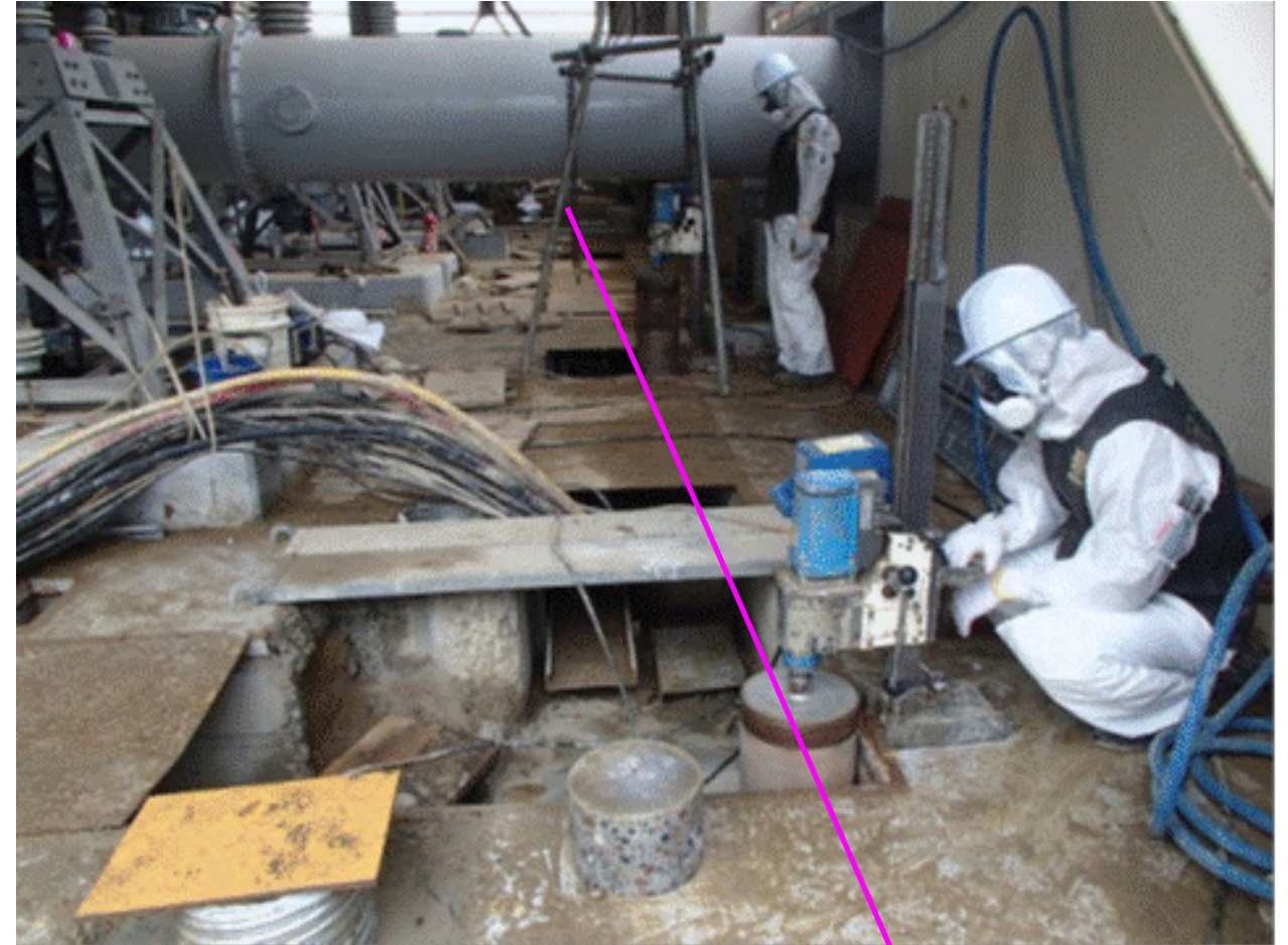
写真④-2 6BLK開閉所にて削孔中
