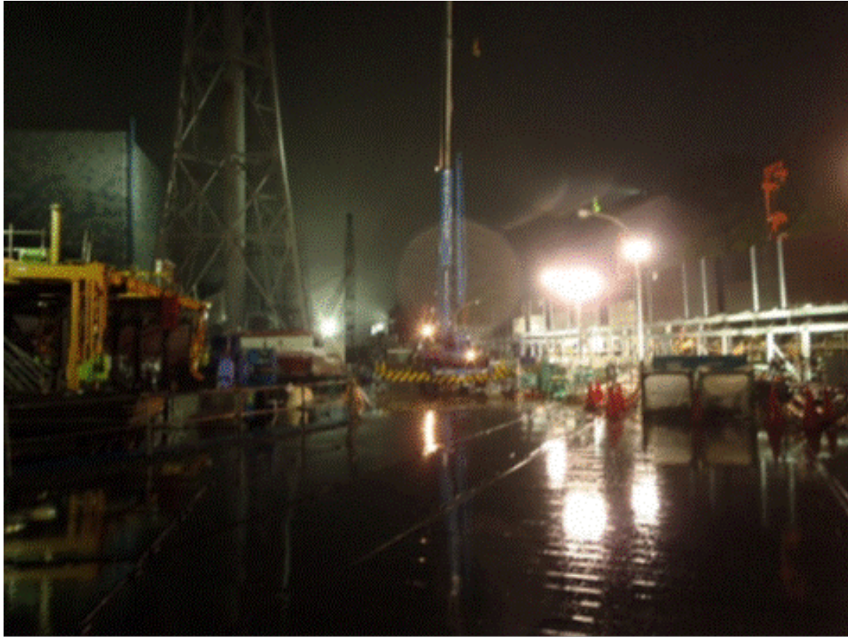
写真③-2 5BLK#1~2電気洞道間 削孔 (2セット)
