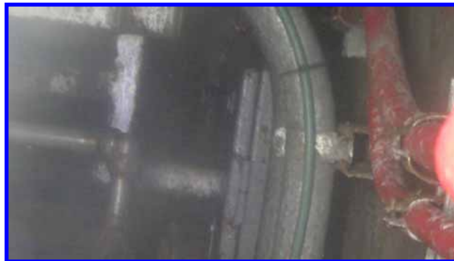
OP.7,200付近: 障害物のため、確認できず
