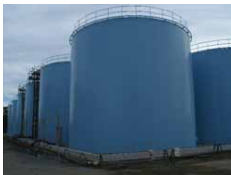
鋼製円筒型タンク（溶接）
