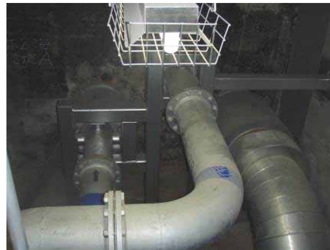
建屋接続部（奥：配管貫通部）
