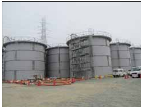
鋼製円筒型タンク
