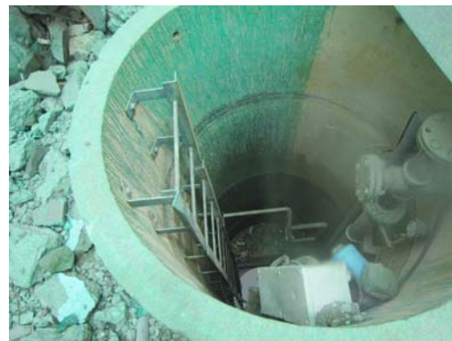
サブドレンピット内部（事故後）
