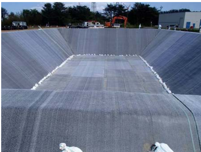
【ベントナイトシート敷設完了】
