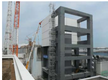
鉄骨建方進捗状況（4/23）
