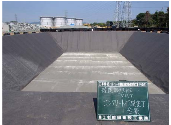
【保護コンクリート打設完了】
