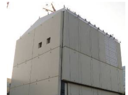
1号機原子炉建屋カバー設置
