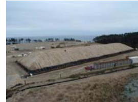
1 槽目の状況 (3/27撮影)
