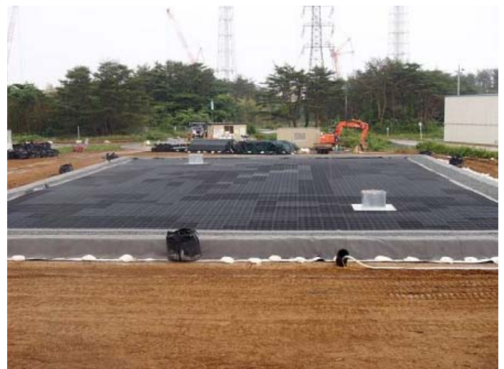
【貯水材組立完了】
