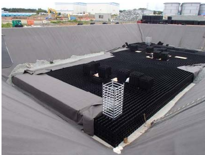
【貯水材組立状況】
