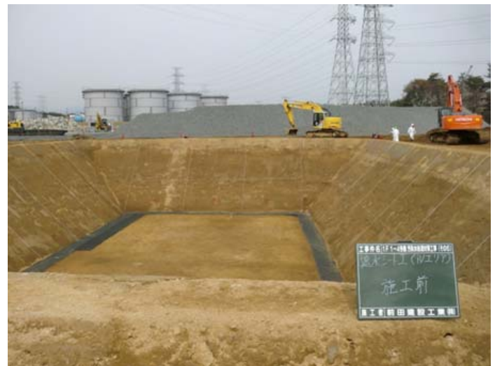
【掘削・地盤改良完了】
