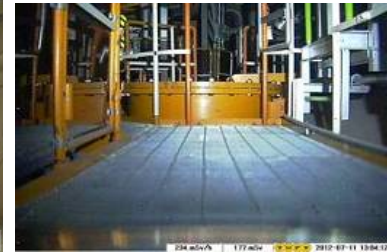
ロボットによるトラス室調査(H24/7/11)
