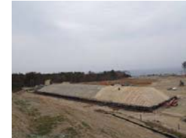
2 槽目の状況 (3/25撮影)
