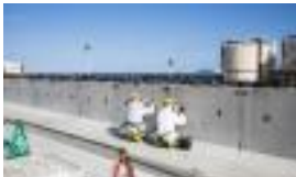
千島海溝津波防潮堤の仕上げ作業
