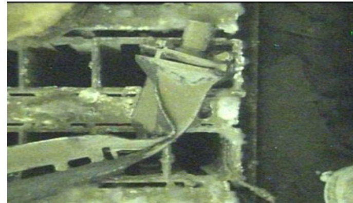
制御棒下部に変形
