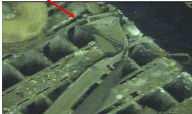
制御棒下部に変形
