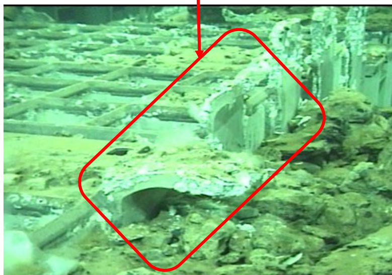
吊りピース変形
