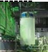
燃料取り出し状況
