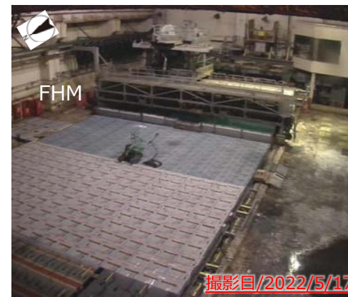
線量測定実施状況
