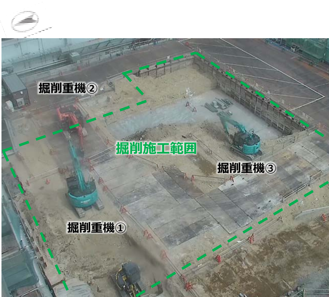
2号機原子炉建屋南側ヤード状況（撮影：2022年5月12日）
