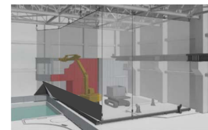
④干渉物撤去 (FHM操作室撤去)
