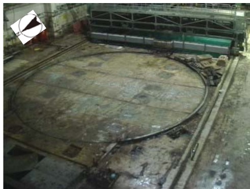
遮蔽設置前の状況
