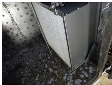
HEPAフィルタ (No.1) 底部に少量の溜まり水を確認
