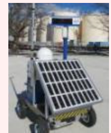
線量率モニタの設置状況
