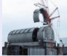
<ドーム屋根設置状況>
