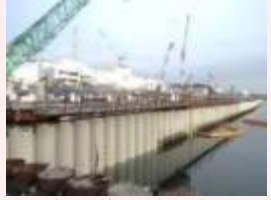
海側遮水壁 鋼管矢板打設完了状況
