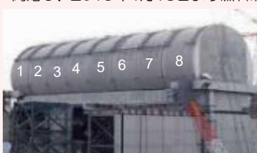
ドーム屋根設置状況 (2019/2/21撮影)
