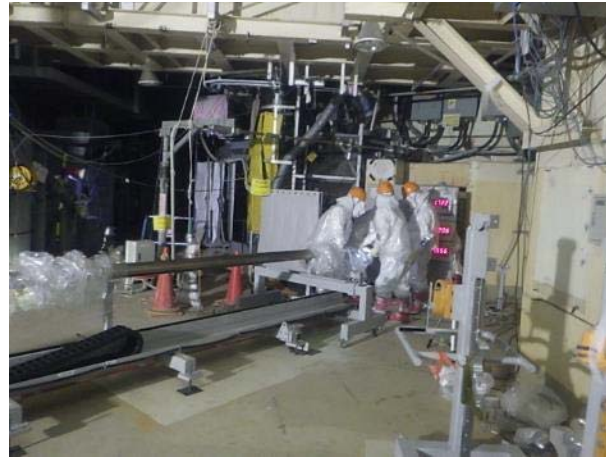
X-6ペネ前での調査装置設置作業
